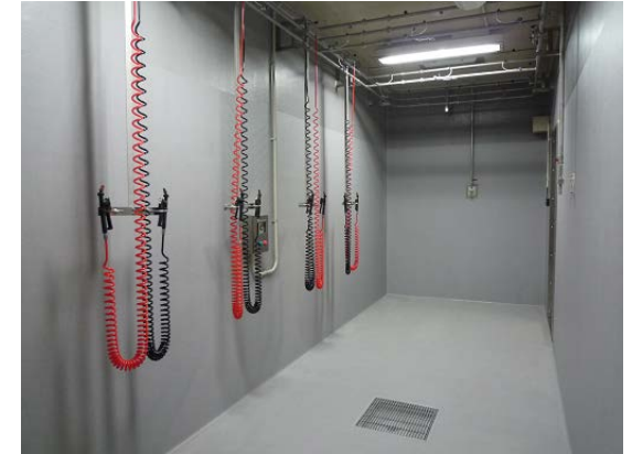
薬液シャワー室
